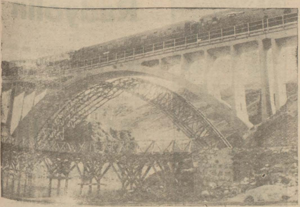
Erzurum hattı üzerindeki beton köprülerden birinden bir katar geçerken
